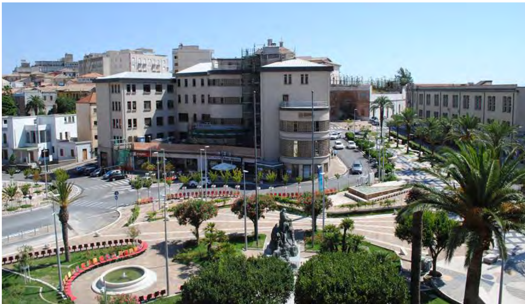
695 – Comune di Catanzaro – Lavori di restauro e completamento di Piazza Matteotti
